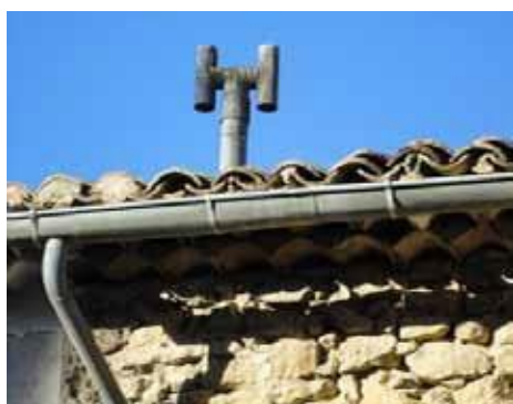
Gaine de ventilation
