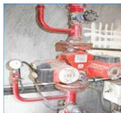
Joints amiantés
