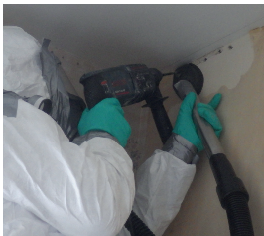
▲ Perçage de peinture/enduit intérieur à travers un embout d'aspiration
