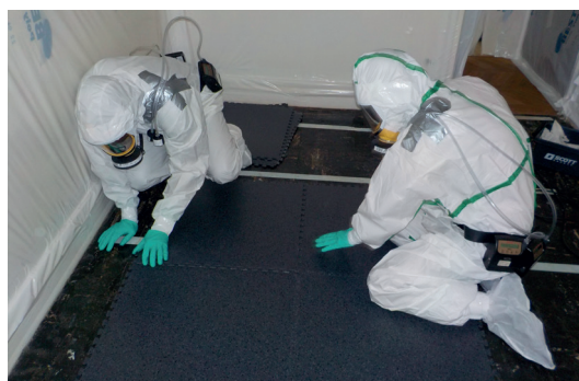
▲ Recouvrement de dalles amiantées par de nouvelles dalles clipsées
