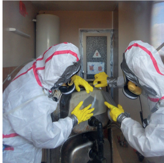
▲ Démontage d'un évier avec tampon bitumineux par humidification à l'aide d'un fixateur
