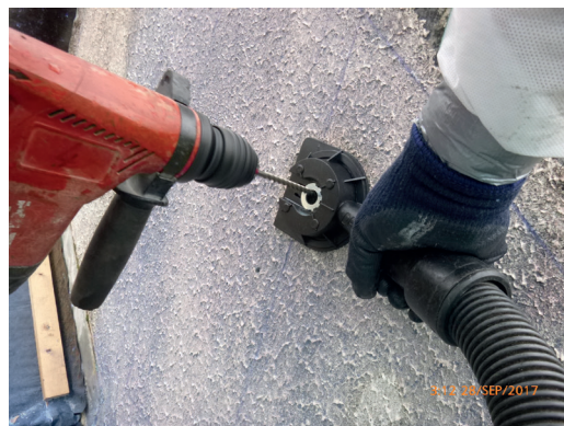
▲ Perçage de peinture et enduit de façade extérieure à travers un embout d'aspiration
