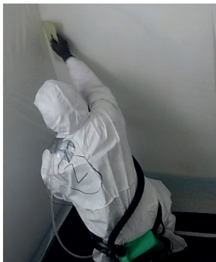
▲ Dépose de papier peint par raclage et humidification du support amianté
