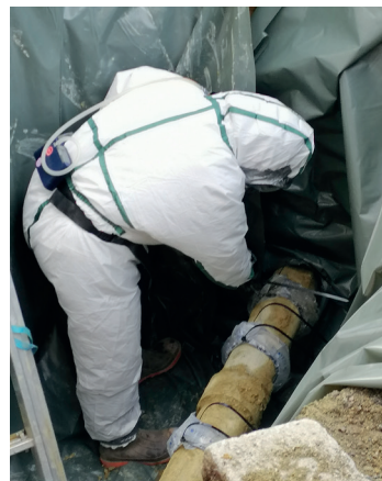
▲ Découpe/démontage à l'aide d'une scie sabre d'un tronçon de canalisation extérieure avec poche de gel hydrique
