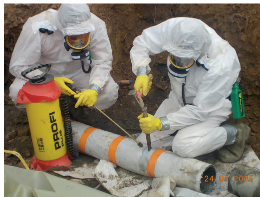
▲ Découpe/démontage à l'aide d'une massette et d'un burin d'un tronçon de canalisation extérieure en amiante ciment et travail à l'humide
