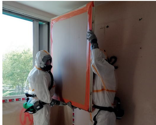
▲ Dépose d'un ouvrant en présence d'un mastic obturateur amianté avec application d'un fixateur
