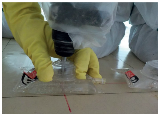
▲ Perçage à travers une poche de gel
