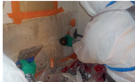
▲ Décollement de quelques carreaux de faïence avec gel hydrique
