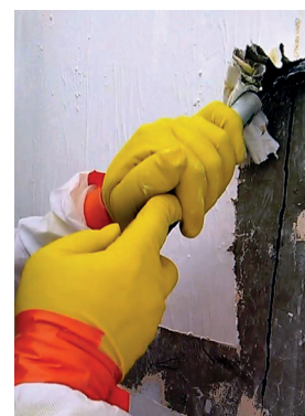
▲ Décapage chimique de peinture et/ou enduit extérieur
