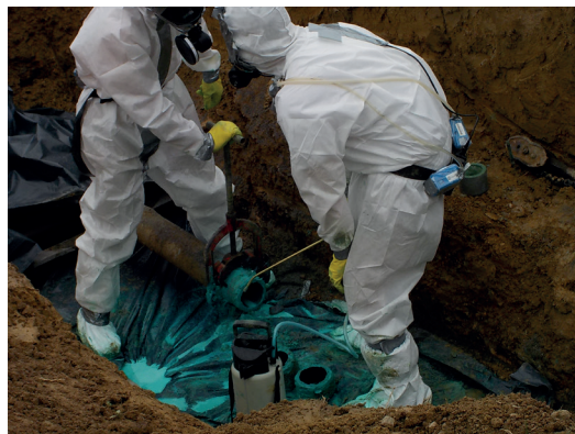
▲ Découpe/démontage à l'aide d'un coupe-tube d'un tronçon de canalisation extérieure avec travail à l'humide
