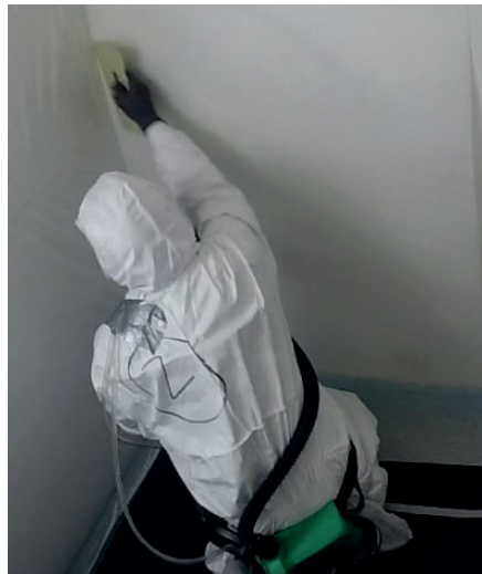
▲ Pose de toile de verre ou papier peint sur peinture ou enduit intérieur
