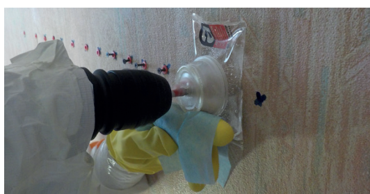
▲ Perçage de peinture/enduit intérieur à travers une poche de gel hydrique
