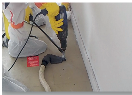
▲ Perçage à travers un dispositif de captage à la source
