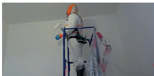
▲ Application d'une peinture sur un mur recouvert d'une peinture ou d'un enduit amianté
